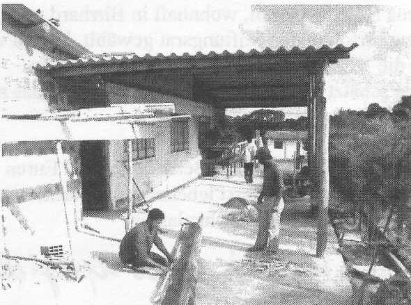
Der Anbau nimmt Gestalt an
