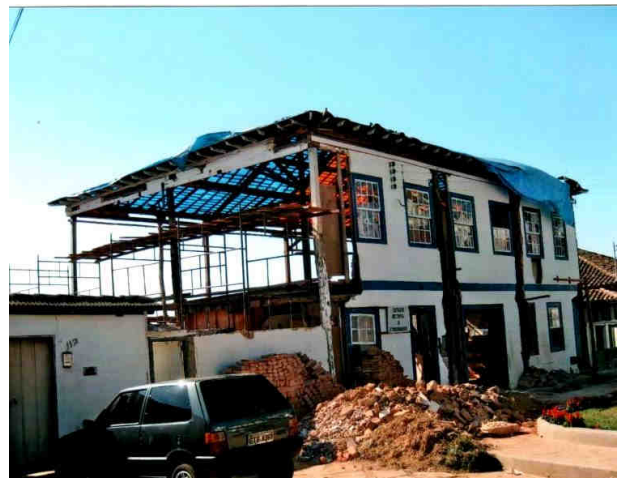
Das selbe Haus, strassenseitig, während des Umbaus durch die Gemeinde
