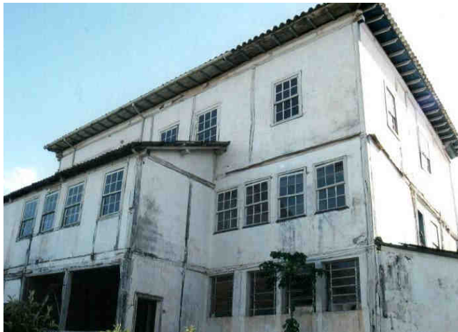
Talseite des „Hauses Orlandi“ vor der Renovation
